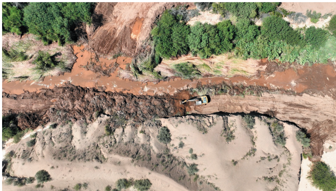
Trabajos. Personal y maquinaria de Vialidad Nacional trabaja en forma ininterrumpida en a zona de los ríos La Punta y Colorado en Villa Mazán
