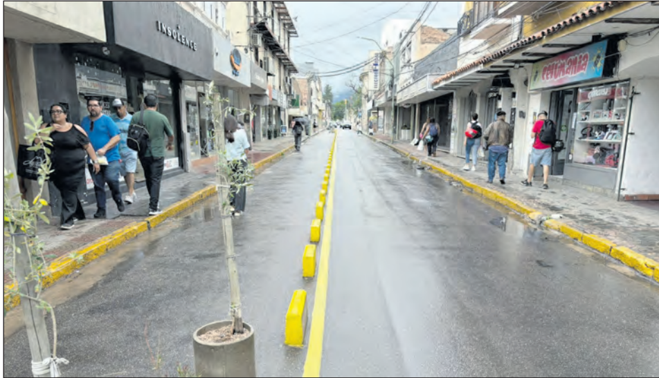
La calle Pelagio B. Luna a poco de haberse realizado los primeros trabajos para su peatonalización.
