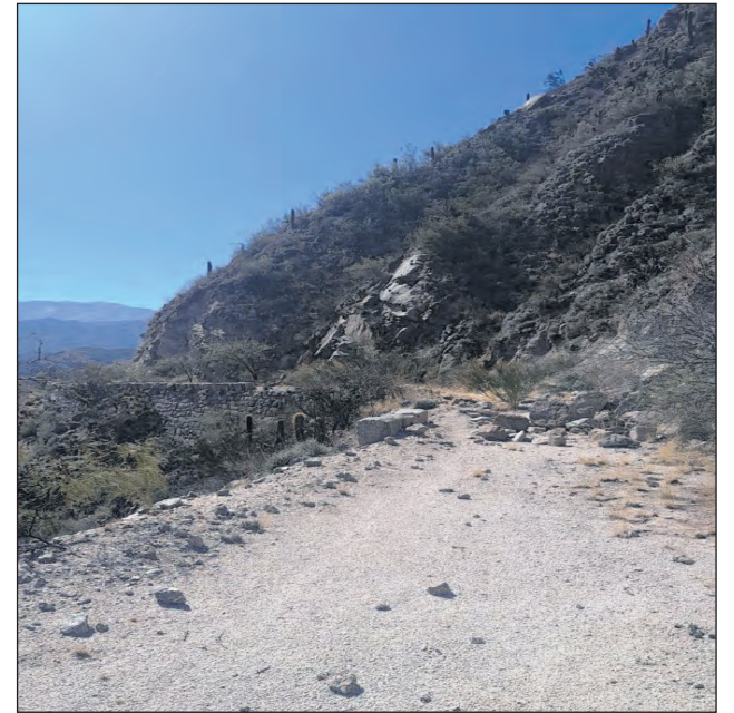
Los picapedreros tallaron las piedras usadas a modo de contención en los tramos más peligrosos.
